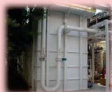
沉澱池變更為脫硝槽
