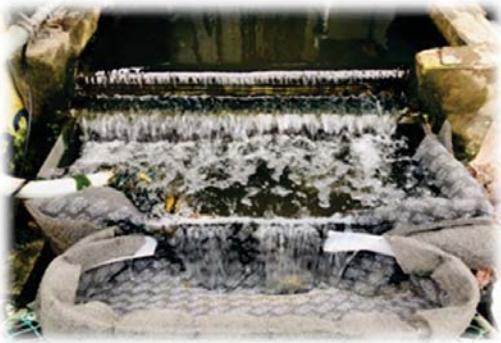
放流口設有過濾棉
