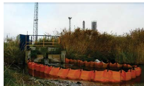
放流口處設置過濾設施
